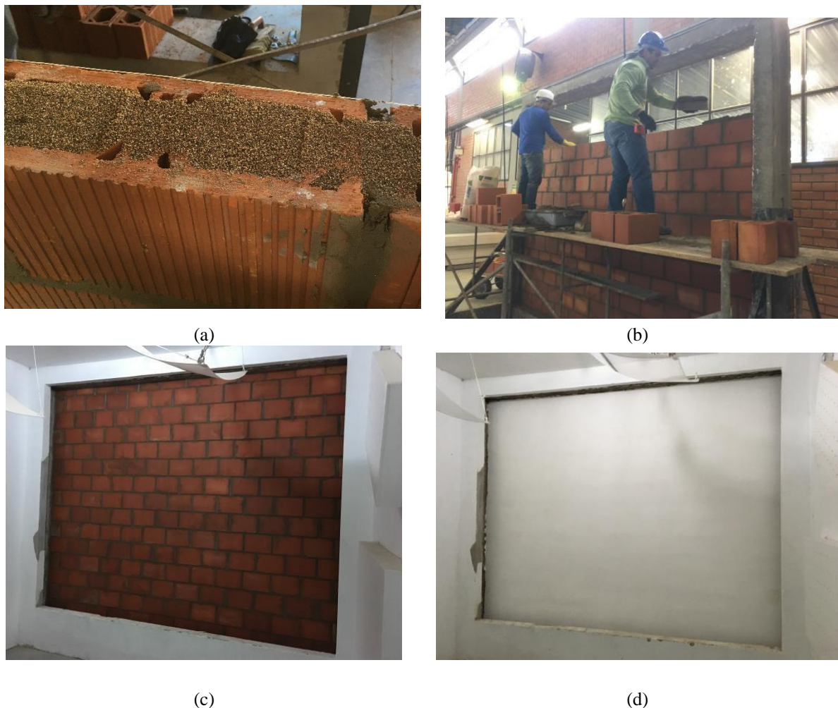
Figura 2: Etapas de construção das amostras: (a) preenchimento dos blocos com vermiculita, (b) construção das alvenarias fora da câmara, (c) amostra sem revestimento instalada na câmara, (d) amostra com revestimento instalada na câmara.
