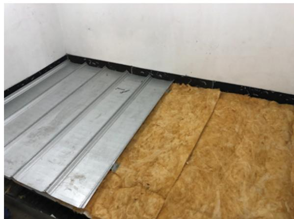
**Figura 11:** Instalação da telha zipada.
