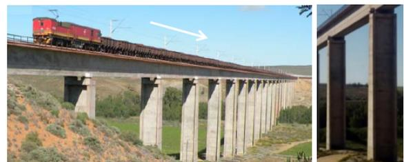
**Figura 13:** Pilares em duplo T: (a) visão panorâmica e (b) detalhe no pilar (retirado de Bussata e Moyo [67]).
