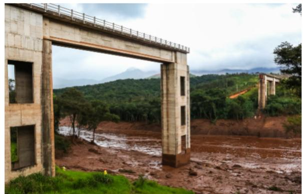
**Figura 12:** Pilares de ponte férrea em duplo C associado por lintéis horizontais (retirado de Brumadinho [66]).
