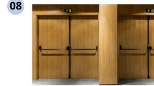
08 Porta acústica em madeira freijó catedral de 2,10x1,80m
