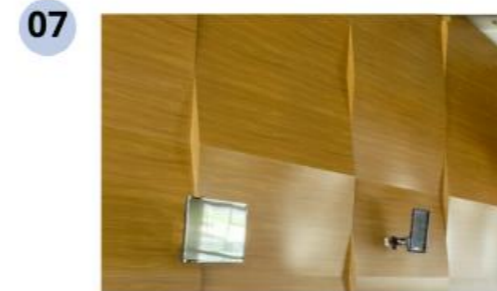
07 Painel vibrante, ótimo para absorção de baixas frequências, em MDF Freijó com enchimento de lã mineral
