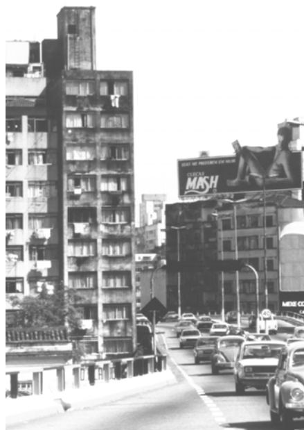
Foto 2. Prédios degradados, principalmente por excesso de poluição sonora, nas laterais do “Minhocão”, em meados dos anos 80, em São Paulo.
