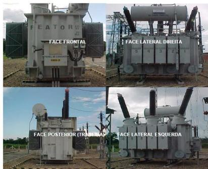
Figura 1: Reator elétrico trifásico 30 MVar – 242 MVA.
