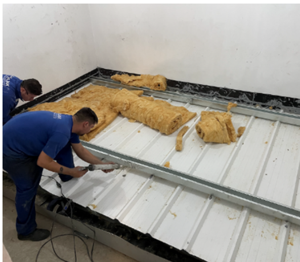
Figura 8: Instalação do sistema de cobertura na câmara.
